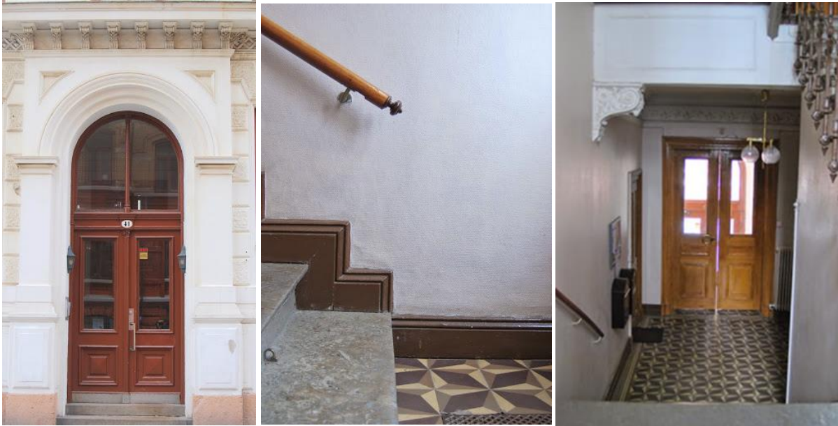
Figur 16, 17 och 18. Port, förstuga och trapphall på Storgatan 41
