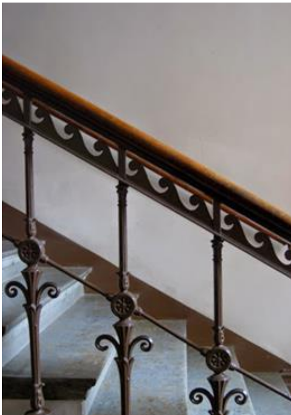
Figur 19. Trappräcke i gjutjärn
