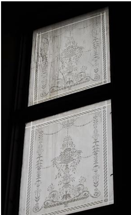
Figur 34. Etsat glas i trapphusfönstren på Karl Gustavsgatan 1a
